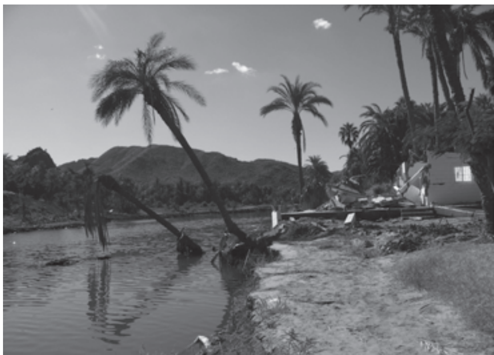
Daños por derribos y ampliación del perímetro urbano en Mulegé. Foto Antonio Ortega Santos
